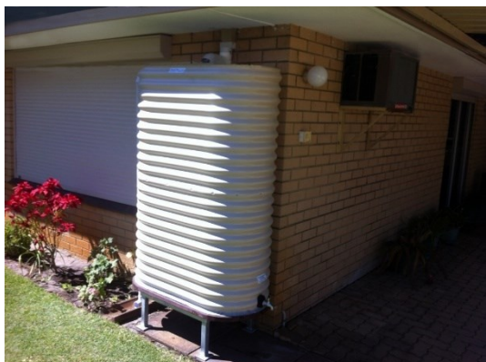
Zdjęcie 2 Przydomowy zbiornik na wodę opadową 16
